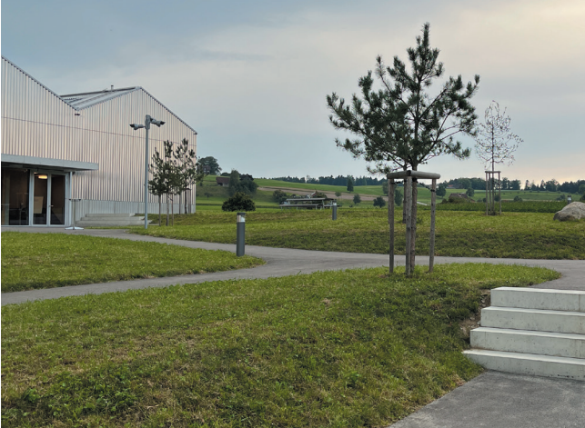
Pausenplatz nach Fertigstellung
